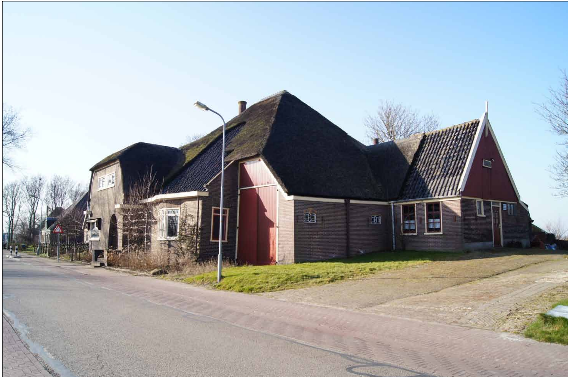
Afb. 14 De oostgevel van de voorste stolpboerderij met rechts de staart.
