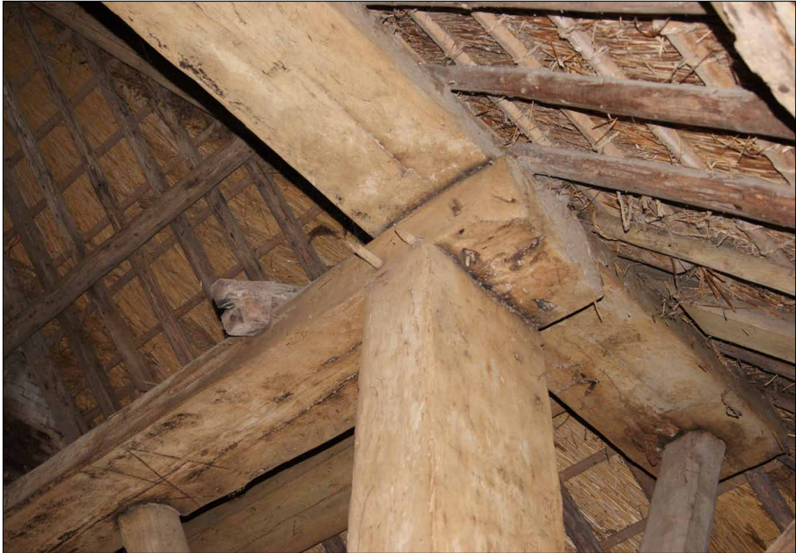
Afb. 24 De verbinding tussen een vierkantstijl (noordwesthoek) en onderste dekbalk, geborgd met twee eiken toognagels. Rechts hiervan is de onderkant van een ijzeren spiebout zichtbaar, waarmee de overstekbalk met de bovenste dekbalk was verbonden.
