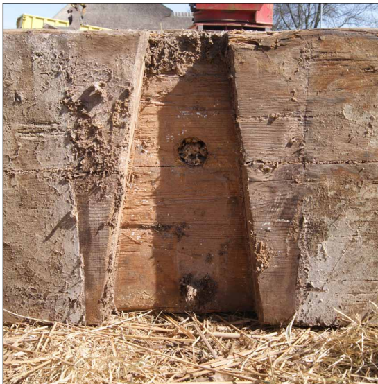
Afb. 25 Tapse inkeping in de onderzijde van de bovenste dekbalk aan de zuidkant, op de locatie waar deze dekbalk op de onderste dekbalk lag. De balken waren hier verbonden door middel van één eiken toognagel.
