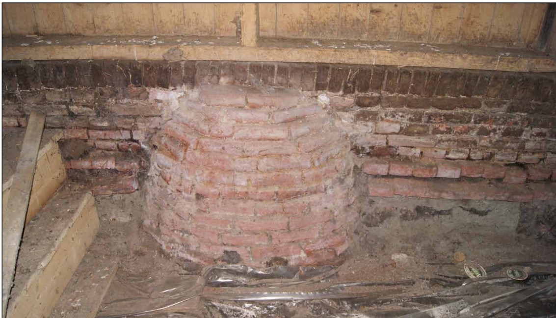
Afb. 41 De waterput met bakstenen koepel tussen de zuidelijke vierkantpoeren.
