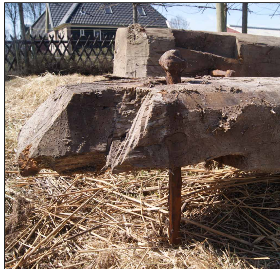
Afb. 26 Uiteinde van de bovenste dekbalk aan de noordkant. De dekbalk was hier verbonden met de onderste dekbalk door middel van een lange ijzeren nagel.
