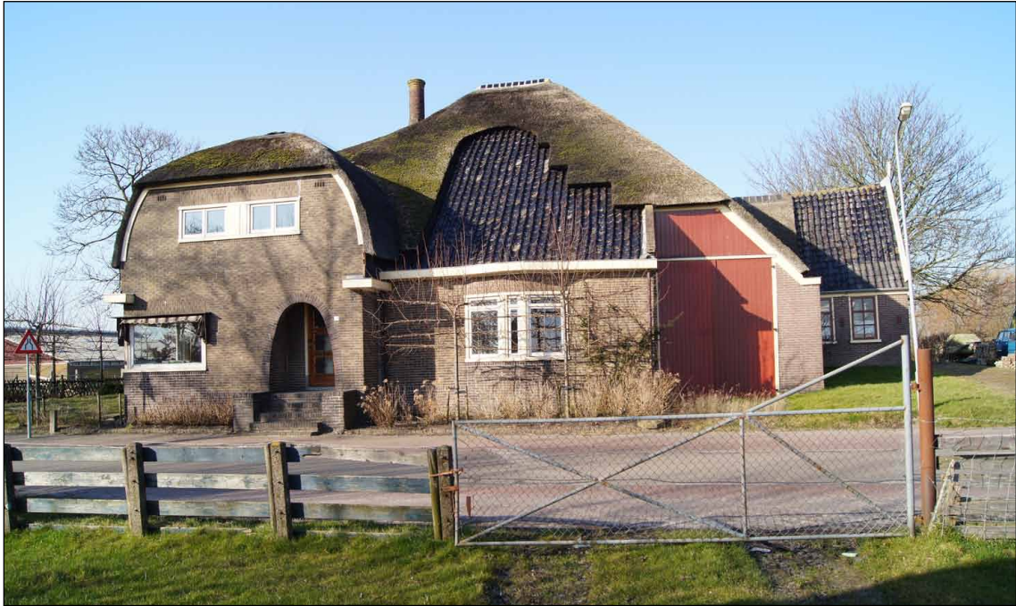
Afb. 12 De voorgevel (zuidgevel) van de voorste stolpboerderij.
